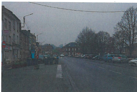
L'ensemble sera rénové pour plus de sécurité
