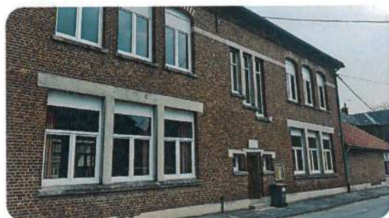
Remplacement des fenêtres de la mairie et de l'école de musique
